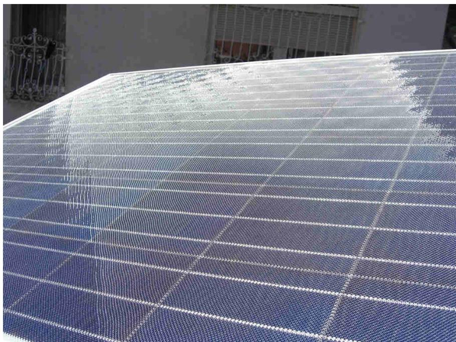
steiler Einstrahlwinkel, steiler Blickwinkel, maximale Reflexleuchtdichte ca. 20.000 cd/m<sup>2</sup>
