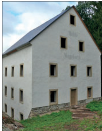
Beispiel für LEADER-Förderung in Oberschöna - die Sanierung des Mühlenturms im Komplex der Wegefarther Mühle
