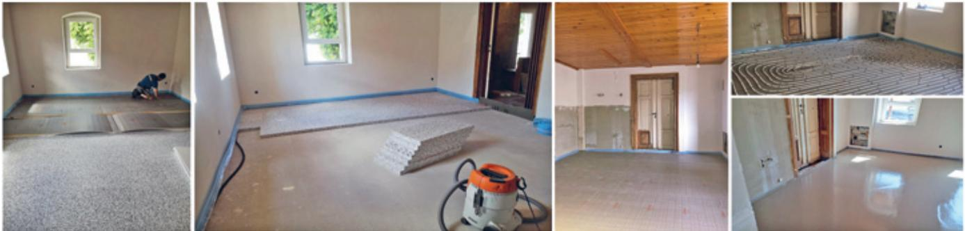
In der Gaststube wurden alle Putzarbeiten abgeschlossen und die Unterdämmung für die Fußbodenheizung ausgelegt. Im Kaminzimmer wurde der alte Teppich entfernt. In der Küche gibt es keine bemerkenswerten Fortschritte. Zuletzt wurden Fußbodenheizungsrohre verlegt und der Estrich gegossen.
