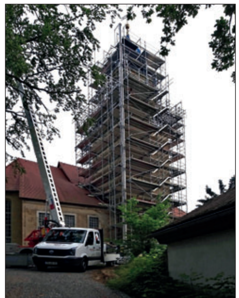
Der Turm der Oberschönaer Kirche wird 2018 restauriert.
