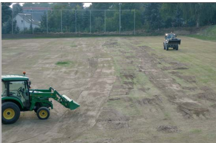
So begann die Sportplatzsanierung.
